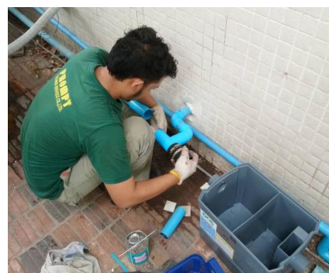
การจัดการน้ำทิ้งจากห้องอาหาร : ติดตั้งถังดักไขมัน
